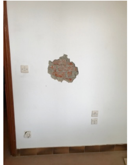
- muro mattoni pieni di spina 3
