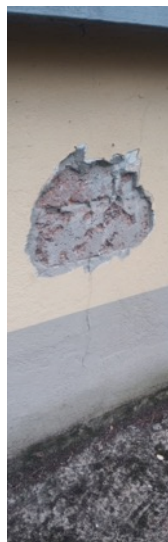
- Saggi murature perimetrali parti esterne e interne - Ampliamento 1960 -
