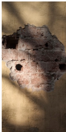
- Saggi murature perimetrali parti esterne e interne - Ampliamento 1960 -
