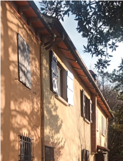
- Differenza d'altezza d'imposta di gronda facciata Ovest - Ampliamento 1960 -
