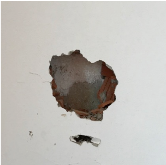
- Saggi murature perimetrali parti interne 1 - Ampliamento1960 -
