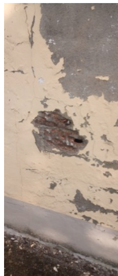
- Saggi murature perimetrali parti esterne e interne - Ampliamento 1960 -
