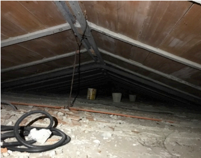
- Saggi sottotetto foto 1 - 2
