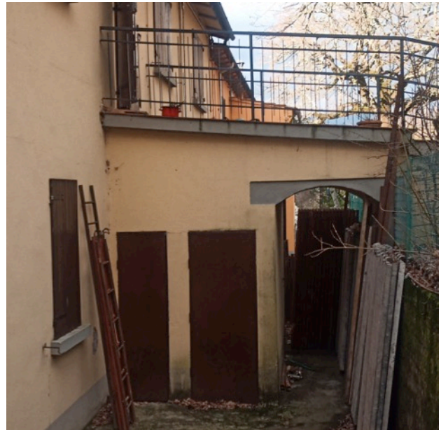
- Passerella lato Est con annesso foto 2
