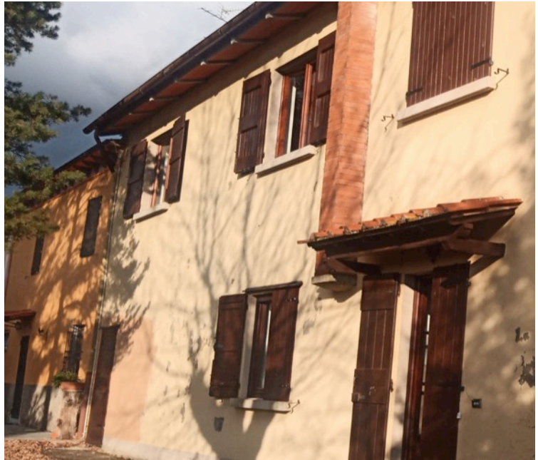
- Differenza d'altezza d'imposta di gronda facciata Ovest - Ampliamento 1960 -
