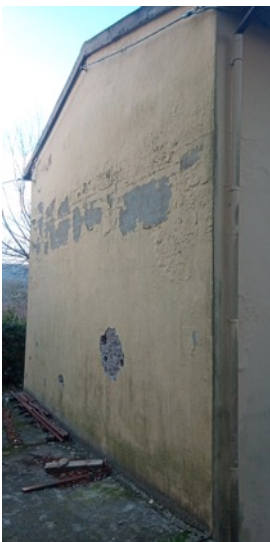
- Saggi murature perimetrali parti esterne e interne - Ampliamento 1960 -
