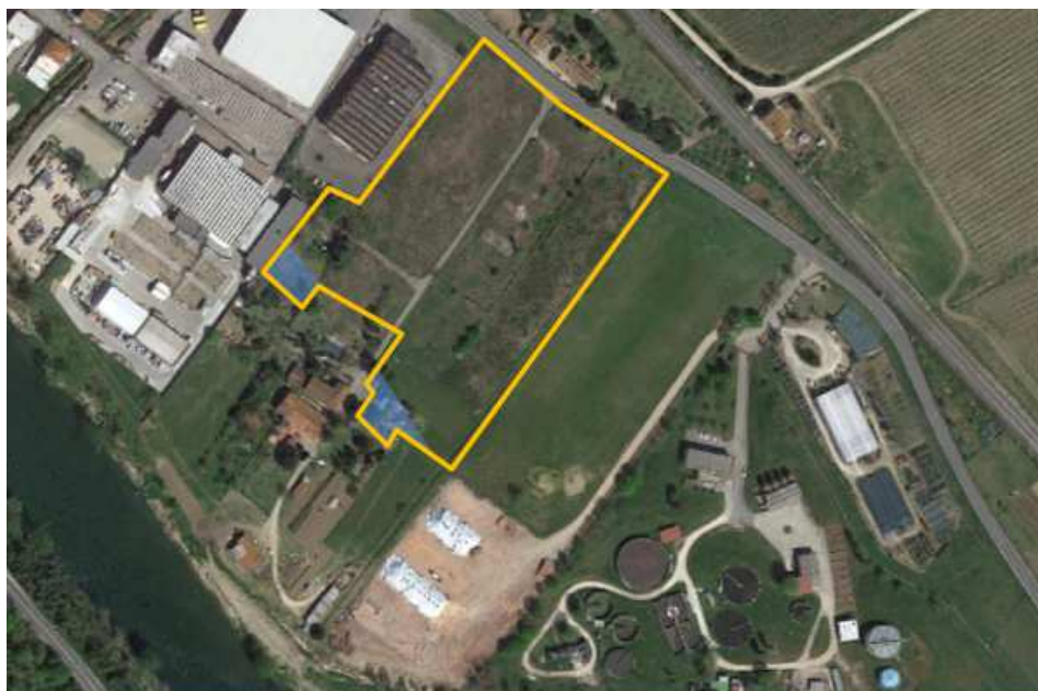
Porzioni dell'area sottoposta a PA che ricadono nel vincolo paesaggistico (velate di azzurro) – Foto aerea Google
