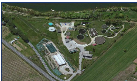
Veduta aerea del depuratore di Aschieto e del vivaio ( http://sigesrl.com/portfolio/pontassieve/ )
